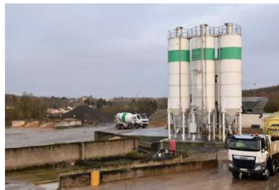
Vue sur la centrale à béton IRIBARREN Béton des Hauts-Fourneaux (ENCERM)
