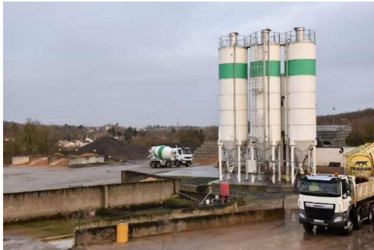
Figure 12 : Centrale à béton IRIBARREN Béton sur le site des Hauts-Fourneaux (ENCEM, janvier 2023)
