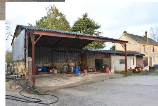
Site des Hauts-Fourneaux : aire de ravitaillement avec zone de stockage des carburants et atelier avec zone de tri (ENCEM)
