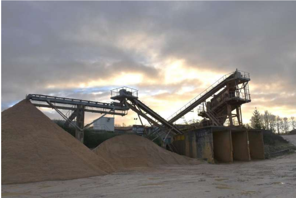
Figure 9 : Installation de traitement du site des Hauts-Fourneaux (ENCEM, janvier 2023)
