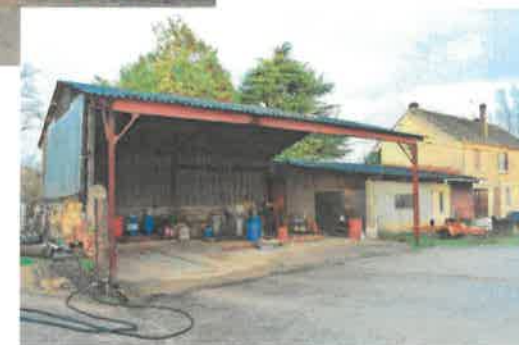
Site des Hauts-Fourneaux : aire de ravitaillement avec zone de stockage des carburants et atelier avec zone de tri (ENCEM)
