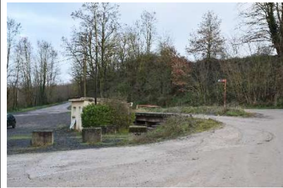
Figure 58 : Site des Hauts-Fourneaux : aire de ravitaillement avec zone de stockage des carburants, atelier, pont bascule (ENCEM, janvier 2023)
