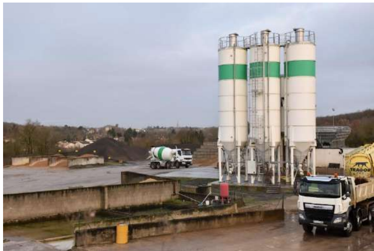
Centrale à béton IRIBARREN BETON sur le site des Hauts-Fourneaux
