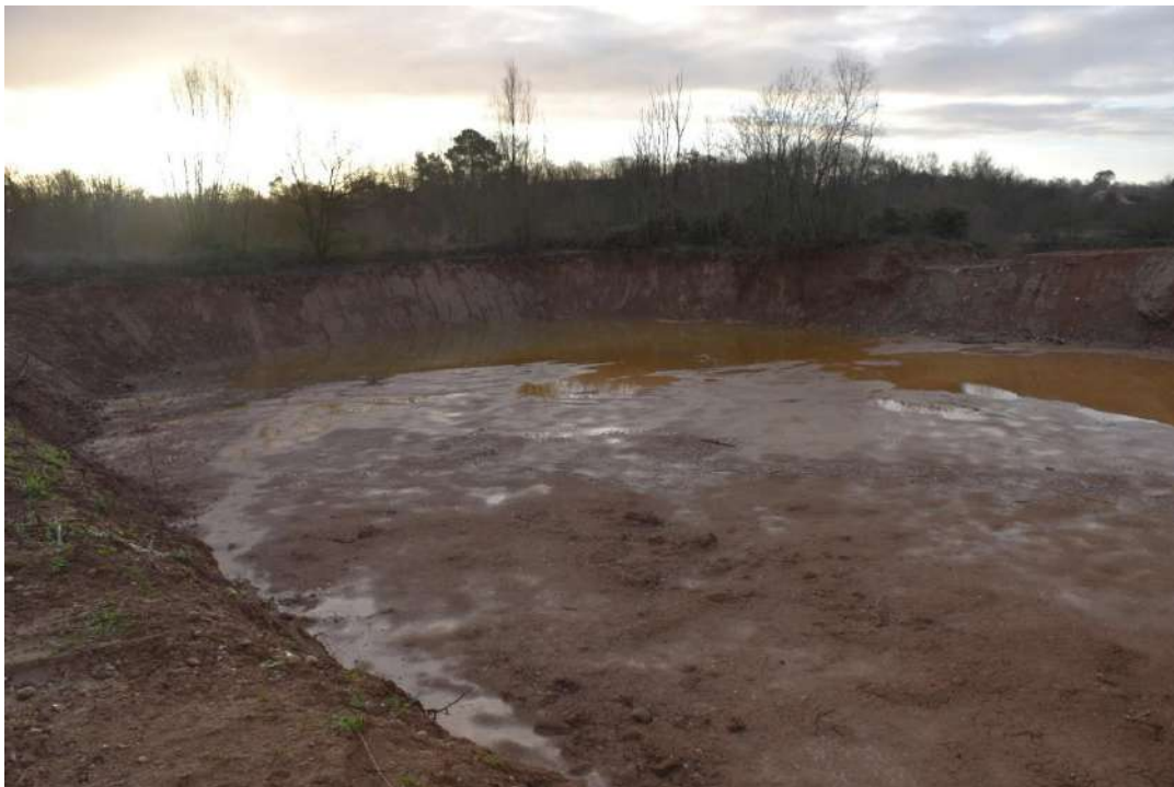
Figure 10 : Exemple de bassin de décantation présent sur le site des Hauts-Fourneaux (ENCEM, janvier 2023)
